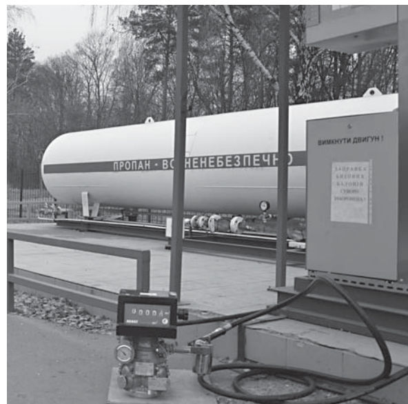
Рис. 2. Повірка еталонним лічильником колонки для відпуску скрапленого вуглеводневого газу
